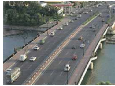
国道58号 明治橋
