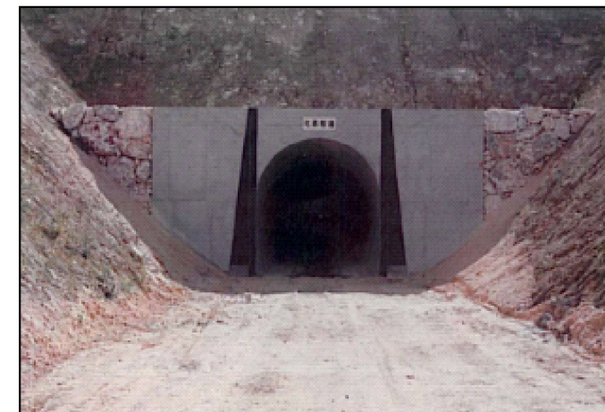
比嘉隧道（ひがずいどう）の工事完成形
