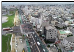
▶令和3年7月 6車線(施工前)
