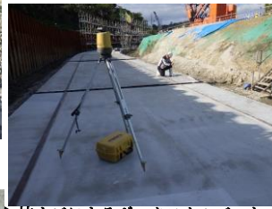
▶杭ナビによるボックスカルバート設置位置出し
