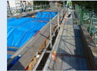
▶足場状況、突起物の見える化が良好
