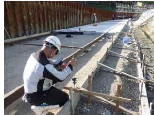
▶杭ナビによる基礎コンクリート通り出し
