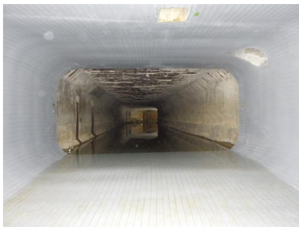
▶寄宮現場写真
