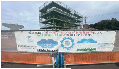
▶①小椋道路橋梁下部工現場
