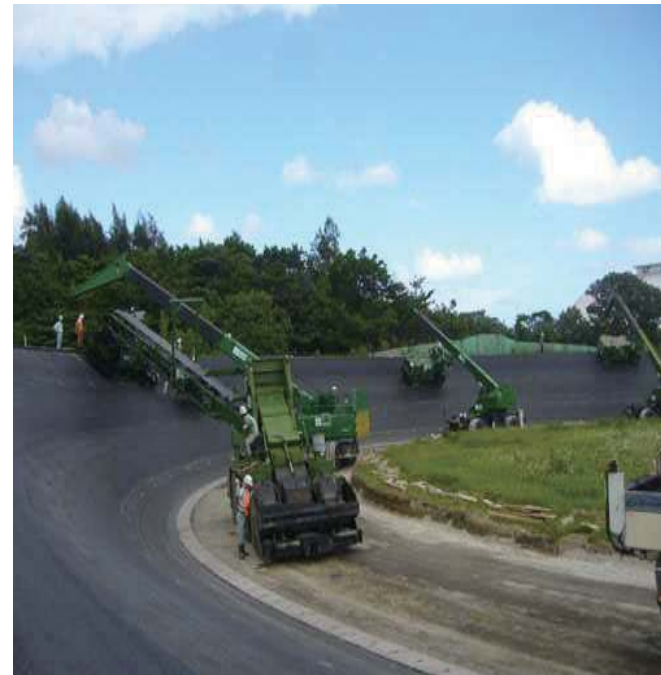
競輪場施工風景
