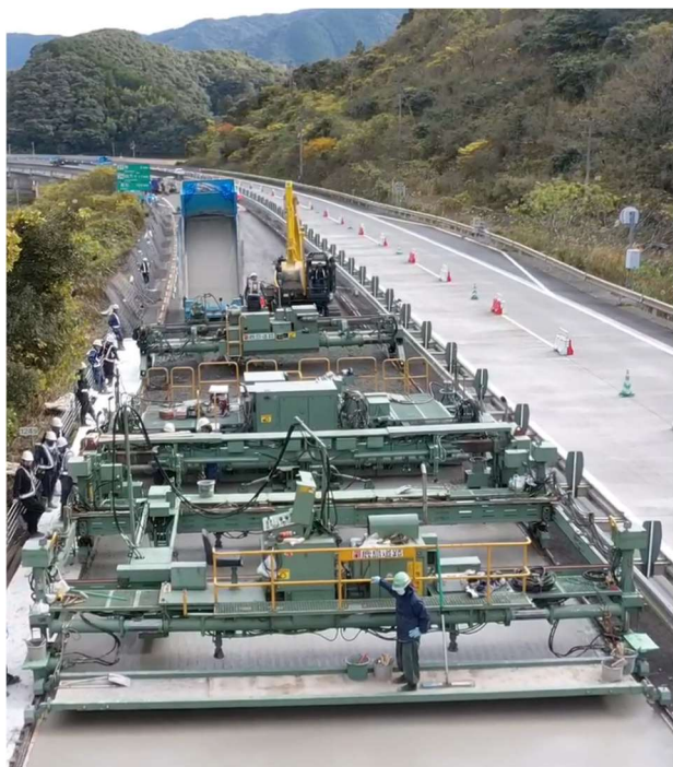
コンクリート舗装の現場指導も行います
