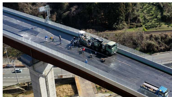
現場ではドローンで空撮も行います
