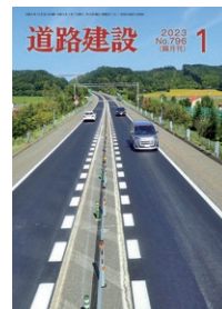
【表紙写真】 帯広広尾自動車道芽室町西土 狩舗装補修工事（北海道河内 郡芽室町）大同舗道株式会社
