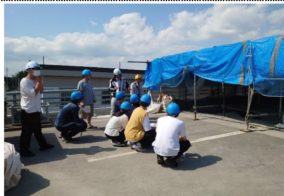
施工状況説明
