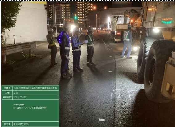
ICT施工見学状況
