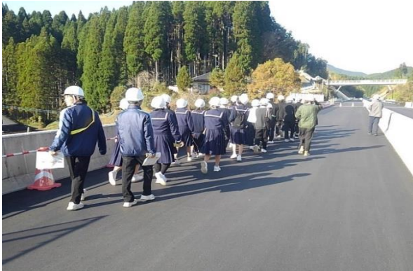
現場見学状況
