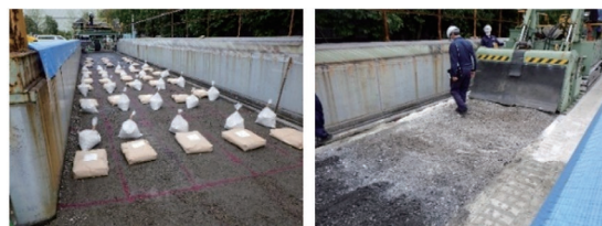
写真－2 100%リサイクル安定処理路盤の施工状況
