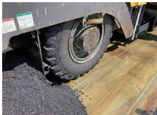
写真-2 接着防水材上での舗設状況
