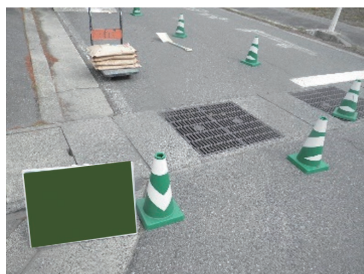
写真-4 施工箇所
