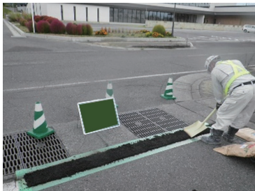
写真-5 施工状況
