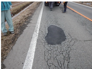
写真-7 補修直後
