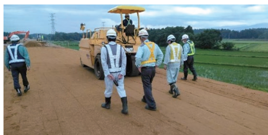
写真-1 ブルーフローリング試験状況
