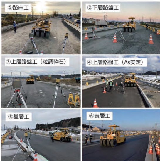
写真－3 舗装全層の計測状況
