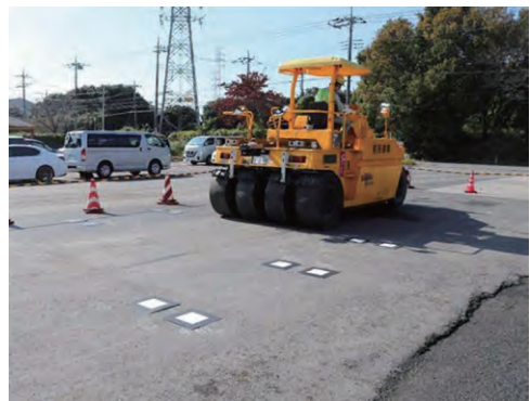
写真-2 アスファルト舗装面の精度確認試験状況
