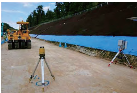
写真-1 路床工の計測状況
