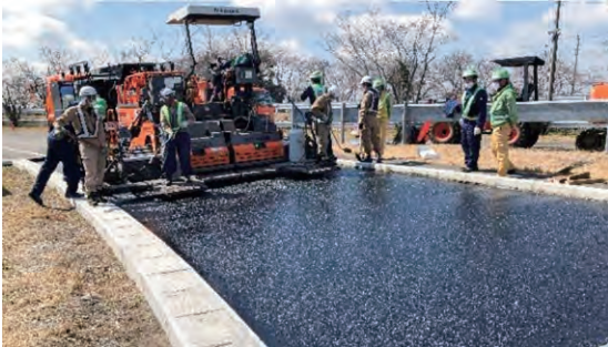
写真－1 試験施工状況
