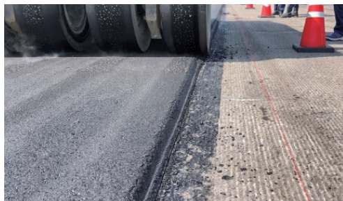
写真-7 舗装端部の転圧状況
