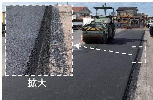
写真-8 継目部(先行レーン)
