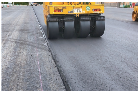
写真-12 舗装端部の転圧状況
