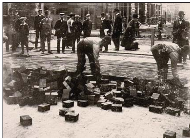
図 1: オスロにおける1914年ごろの木質ブロックの舗装. 写真は1984年のノルディック道路回議で"Väghistoriska utställningen" から入手したもの.
