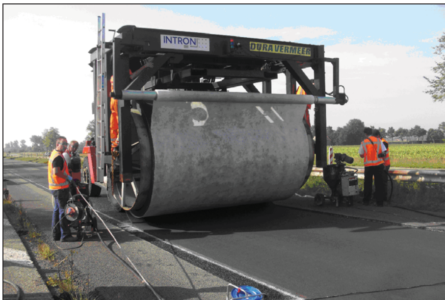
図一 7 ロールペーブの技術を使用しての PERS の施工。2009 年 Kloosterzande のテストトラックでの施工。同じ方法で 2009 年の自動車道のアクセス道路でも施工された。写真はベルギー道路研究所 Luc Goubert 氏提供。
