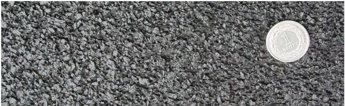
図一 8: 新設時の Nanosoft 路面、2008 年ポーランドの Poznan で施工された。コインの直径は 23 mm。写真はポーランド TUG の Piotr Mioduszewski より。
