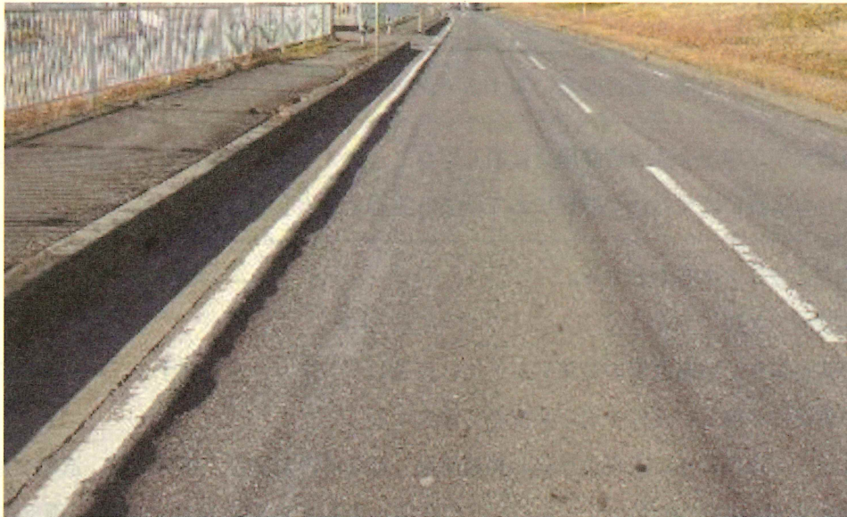
写真 3-1 アスファルト舗装の現況
