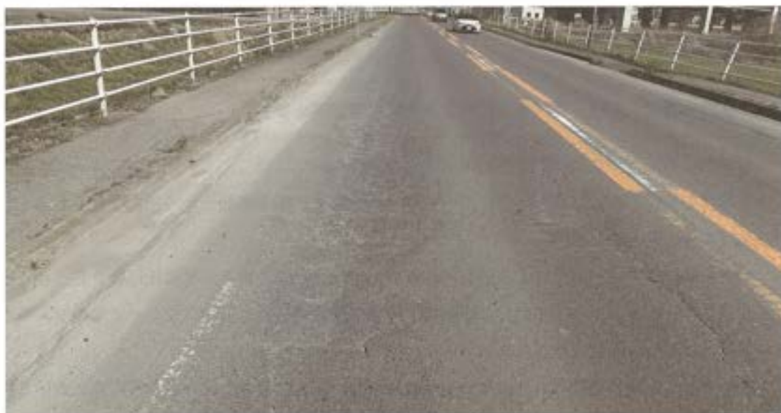
写真3-1 アスファルト舗装の現況
