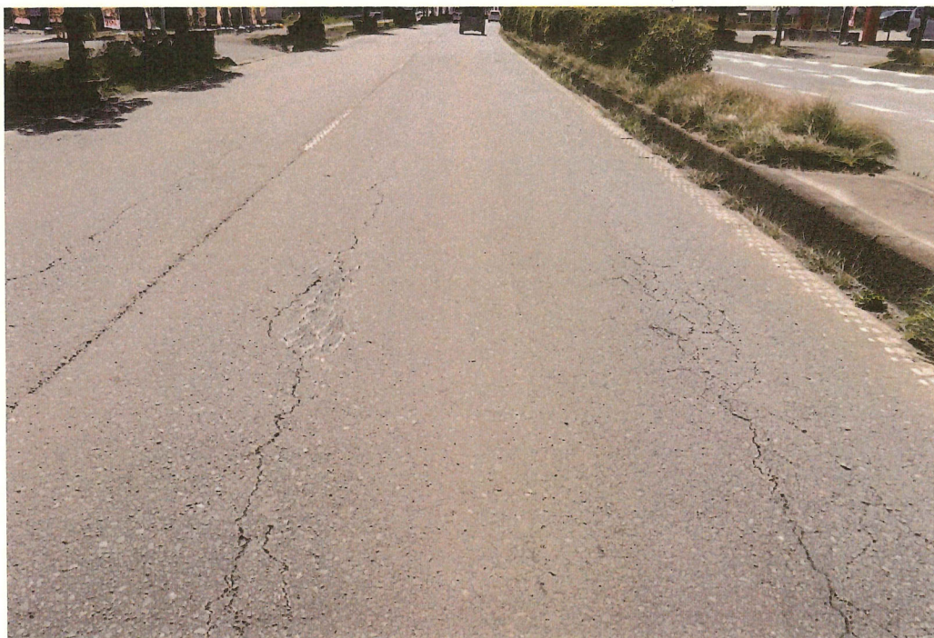
写真 4-1 既設舗装の路面状況
