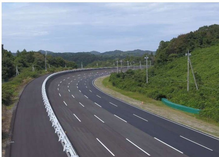
高速周回路改修工事 茨城県東茨城郡城里町 (株)NIPPO
