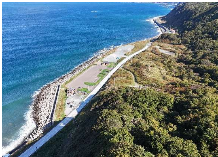
一般国道229号 積丹町 神岬舗装補修工事 北海道 積丹郡 積丹町 地崎道路(株)
