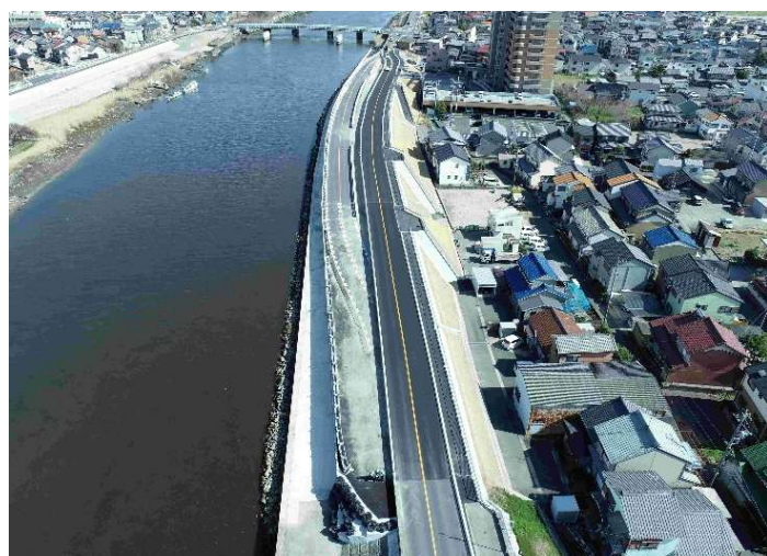
新川(1号工)(ICT簡易・週休2日) 愛知県名古屋市 中部土木(株)
