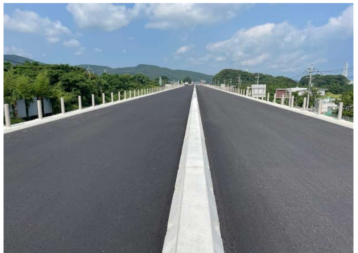
長崎497号松浦IC地区舗装工事 長崎県松浦市 前田道路(株)
