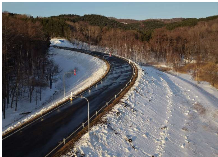
留萌小平線防災B地方道工事（舗装工）（補正・明許） 北海道留萌市 道路工業(株)
