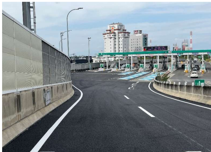
令和7年度 高速16号一宮線舗装改築工事(第4工区) 愛知県一宮市 中部土木(株)
