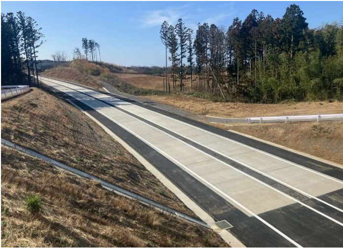
館森地区舗装工事 秋田県にかほ市 世紀東急工業(株)
