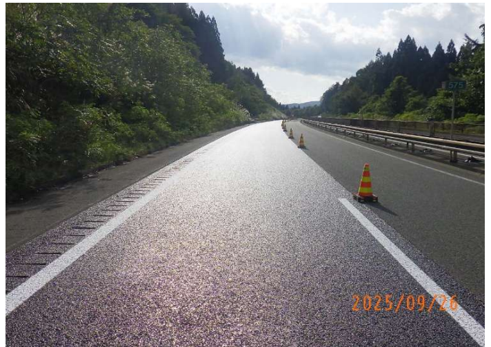
東北自動車道R6松尾八幡平～安代間舗装補修工事 岩手県二戸市 世紀東急工業(株)
