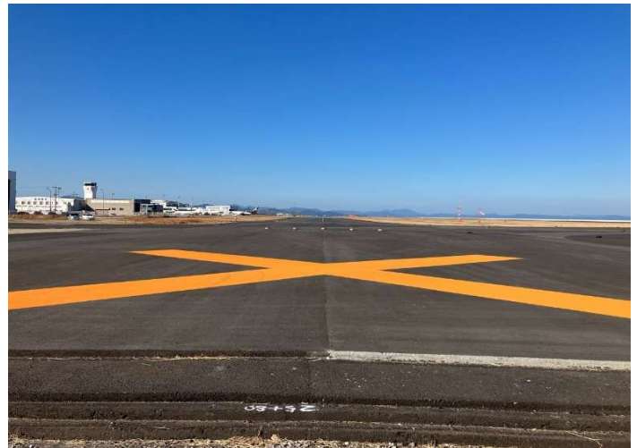
令和6年度北九州空港滑走路延長滑走路新設工事 福岡県北九州市 前田道路(株)
