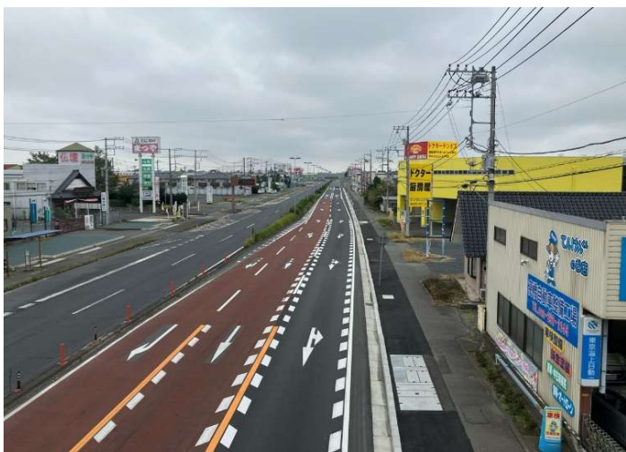
R6国道6号長岡電線共同溝(その2)工事 茨城県茨城町 世紀東急工業(株)
