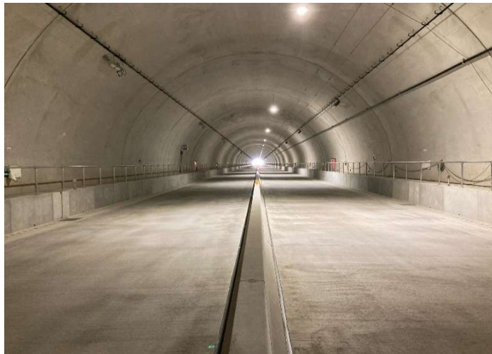
長崎497号松浦2号トンネル（2工区）舗装工事 長崎県松浦市 前田道路(株)
