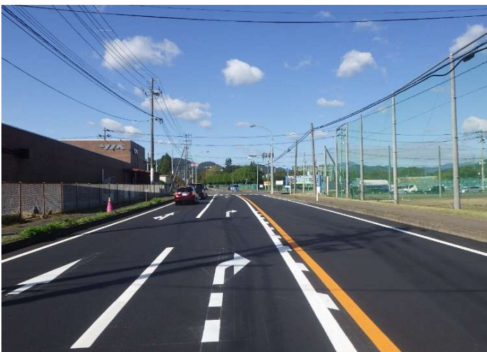
仙台西国道舗装補修工事 宮城県仙台市 日建工業(株)
