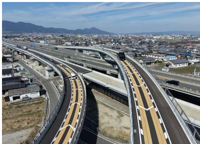
大和御所道路檀原高田ICランプ部北側舗装工事 奈良県檀原市 フジタ道路(株)
