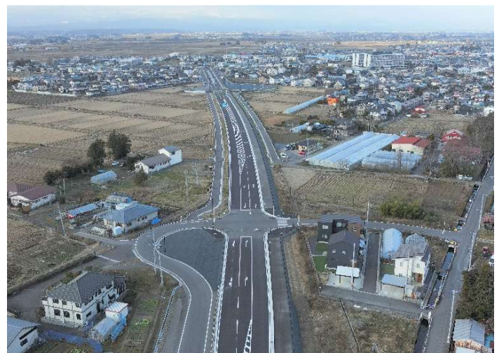
境野宮地区舗装工事 宮城県大崎市 日本道路(株)
