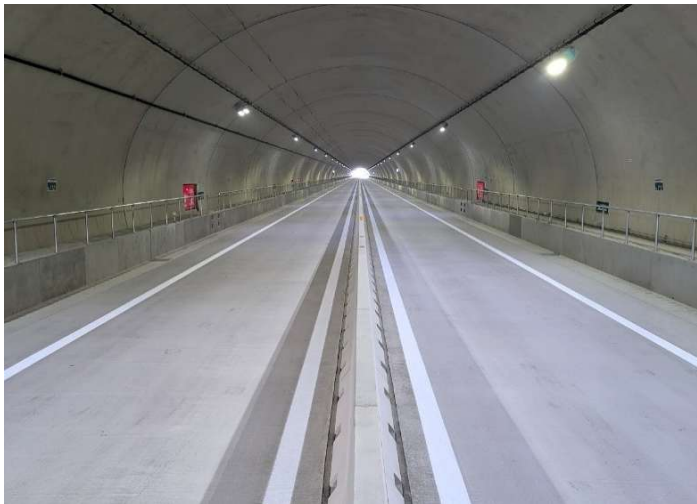
長崎497号松浦1号トンネル（1工区）舗装工事 長崎県松浦市 前田道路(株)
