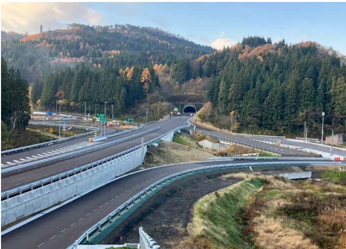
下院内地区改良舗装工事 秋田県湯沢市 世紀東急工業(株)
