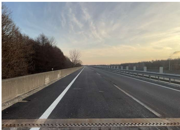
一般国道234号安平町追分弥生舗装補修外一連工事1 北海道安平町・苫小牧市 大同舗道(株)
