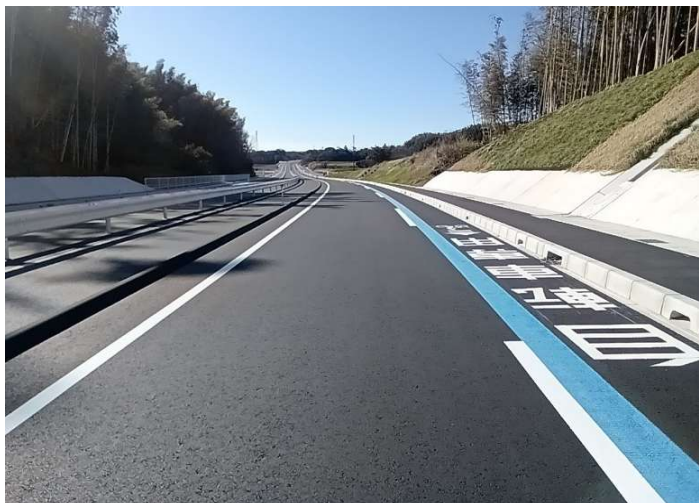
道路改良工事（交付金）(R247R7-3)（余裕期間・ 週休2日・遠隔臨場） 愛知県知多郡 大有建設(株)
