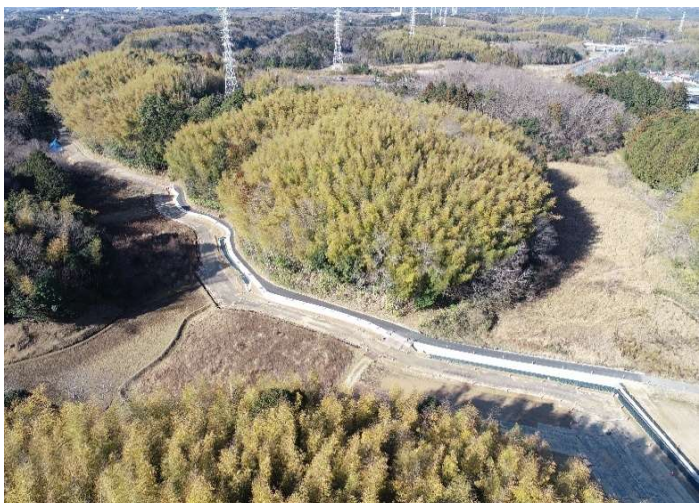
令和5年度 23号中勢道路建設工事 三重県津市 朝日土木(株)
