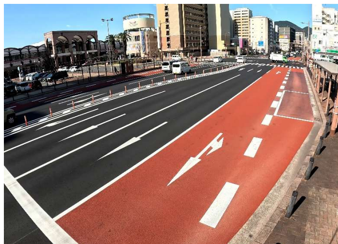
令和7年度長崎管内舗装修繕外工事 長崎県松浦市 吉川建設(株)
