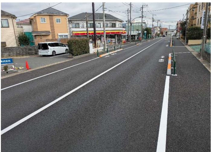
路面補修工事(6二の9) 東京都世田谷区 戸田道路(株)
