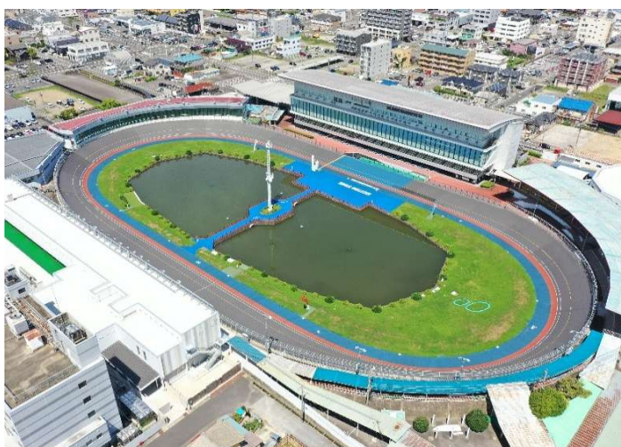
岐阜競輪場競走路塗布工事 岐阜県岐阜市 東亜道路工業(株)
