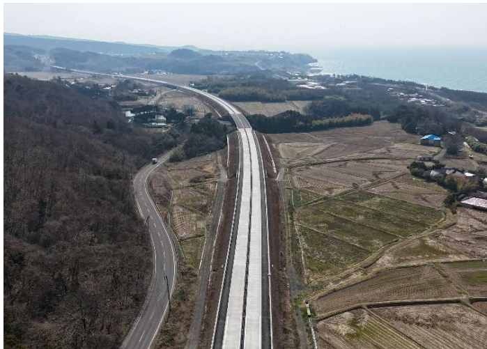
大砂川地区舗装工事 秋田県にかほ市 日本道路(株)
