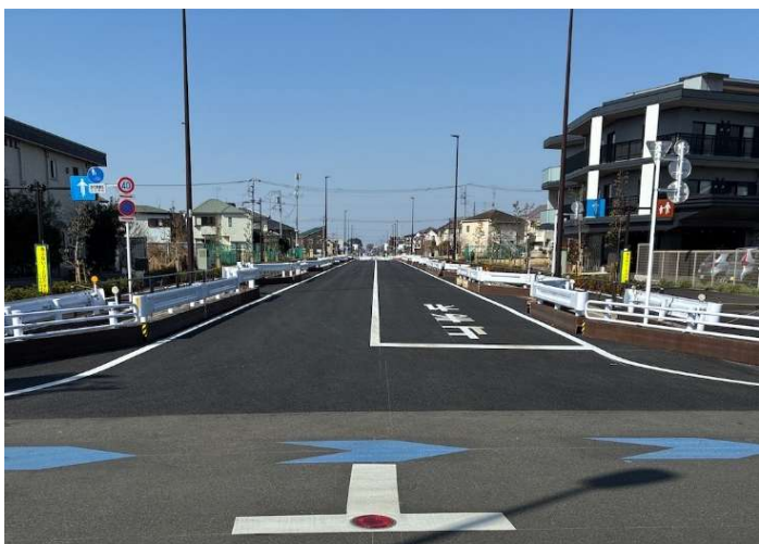
街路築造工事(6四 - 放7大泉学園) 東京都練馬区 戸田道路(株)
