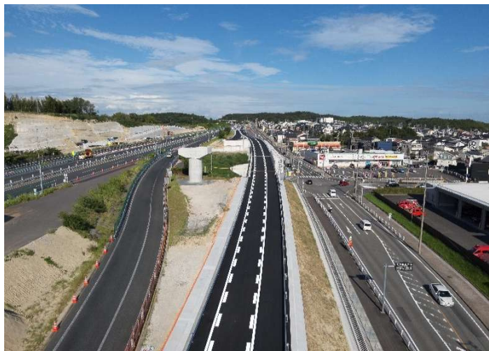
道路建設工事(舗装・西知多6-1号) 愛知県常滑市(常滑JCT) 大有建設(株)
