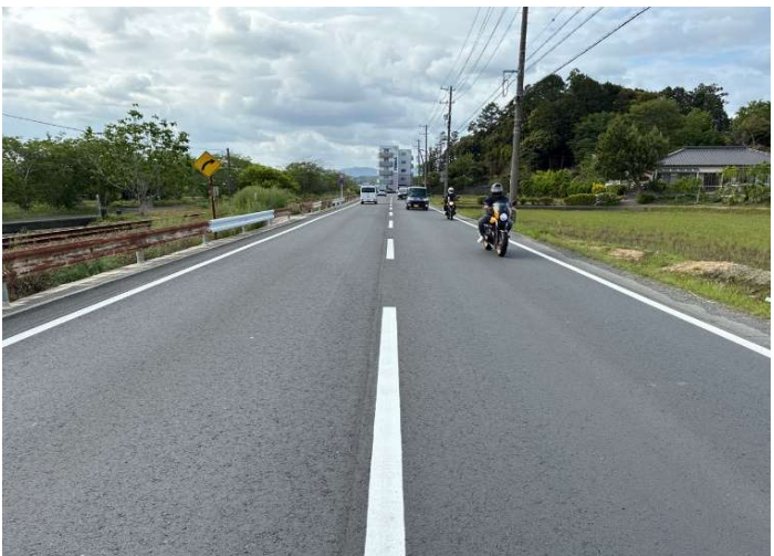
令和6年度 掛川天竜線舗装修繕工事 静岡県掛川市 中村建設(株)
