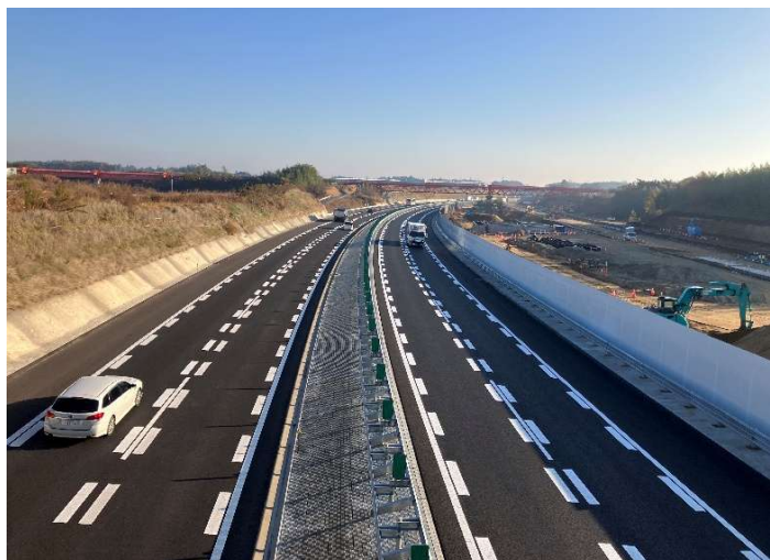
東関東自動車道_成田地区舗装工事 千葉県成田市 世紀東急工業(株)
