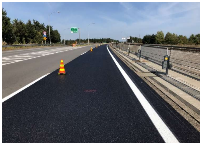
東北自動車道 R6青森管内舗装補修工事 岩手県八幡平～青森県青森市 (株)佐藤渡辺
