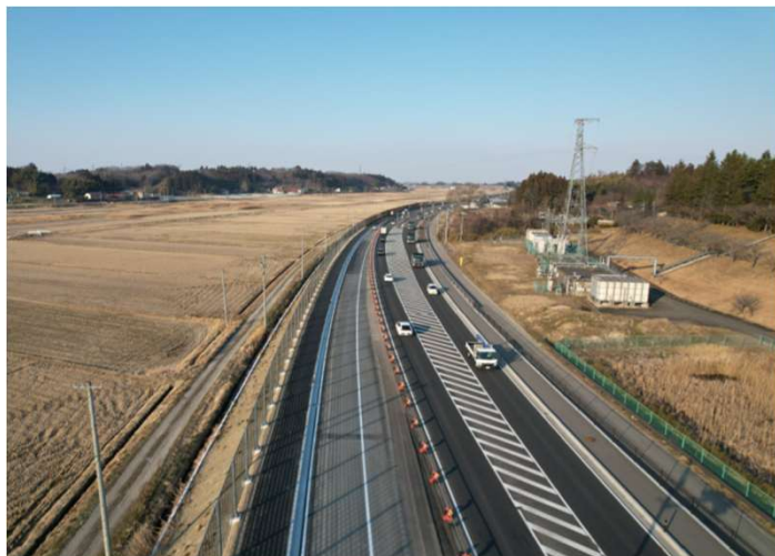
三本木地区改良舗装工事 宮城県黒川郡大衡村 (株)NIPPO
