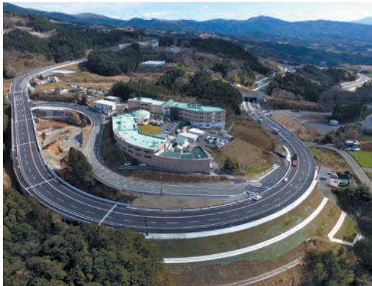
1号笹原山中BP 山中新田地区舗装工事 (静岡県三島市) : 世紀東急工業株式会社
