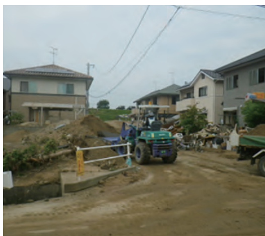
土砂撤去作業：大林道路株式会社
