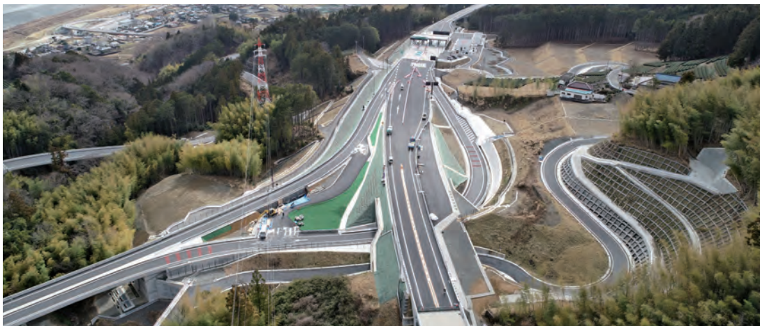
中部横断自動車道新清水JCT～富沢IC間北舗装工事：福田道路株式会社
