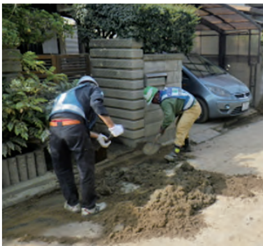
土砂などの清掃作業：大林道路株式会社
