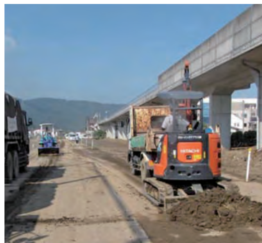
土砂などの清掃作業：東亜道路工業株式会社
