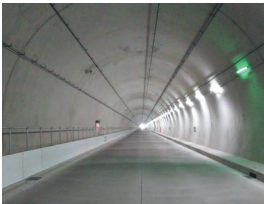
平成31・32年度 新猪ノ鼻トンネル舗装 (徳島工区) 工事 : 株式会社佐藤渡辺
