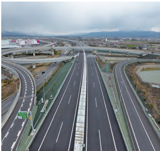
東海環状自動車道 大安～東員IC間舗装工事： 日本道路株式会社
