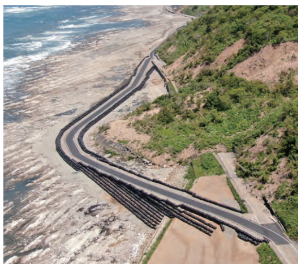
輪島市千枚田付近国道249号迂回路
