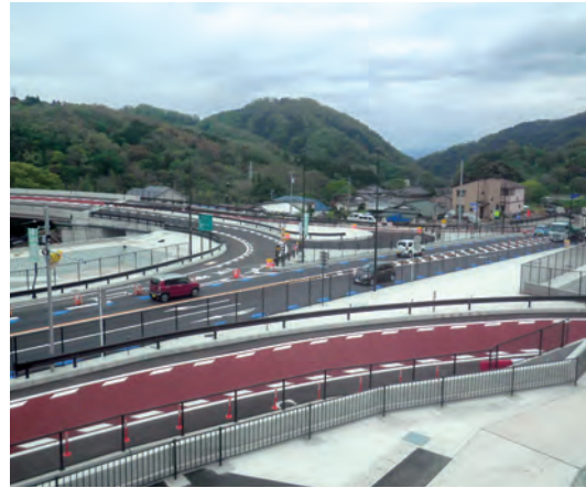
R3国道246号厚木秦野道路秦野西IC改良舗装工 事 (神奈川県秦野市) : 前田道路株式会社
