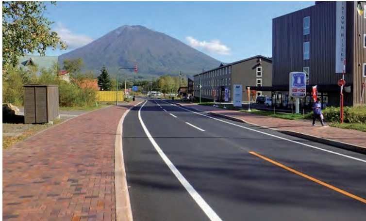
蘭越二七〇俱知安線 電線共同溝工事：鹿島道路株式会社
