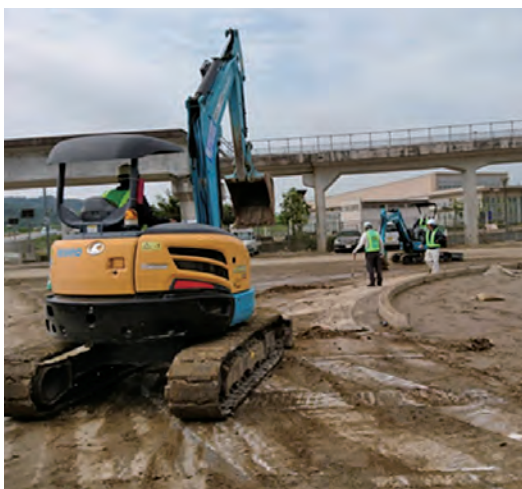
土砂などの清掃作業：前田道路株式会社
