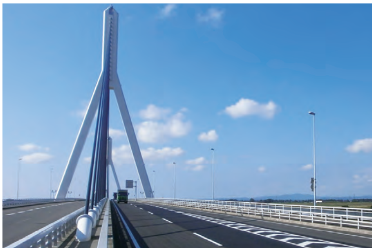
国道337号 江別市美原大橋補修：不二建設株式会社
