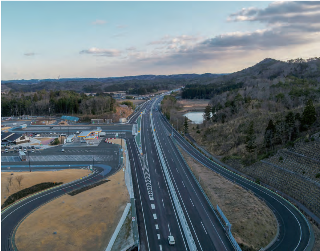
常磐自動車道 南相馬舗装工事 (福島県南相馬市鹿島) : 株式会社ガイアート
