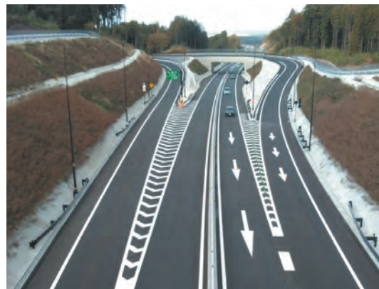
令和元年度 災害復旧 熊本57号古城地区舗装(その1) 工事 (熊本県菊池郡) : 株式会社NIPPO
