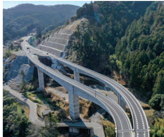
令和3年度 河津下田道路大鍋地区舗装工事(静岡県河津町): 東亜道路工業株式会社
