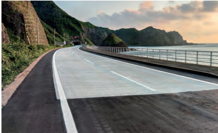
一般国道229号 積丹町 神岬舗装補修外一連工事(積丹町): 地崎道路株式会社
