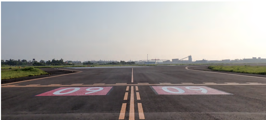
平成30年度 宮崎空港誘導路(S1・S2)改良外1件工事：世紀東急工業株式会社
