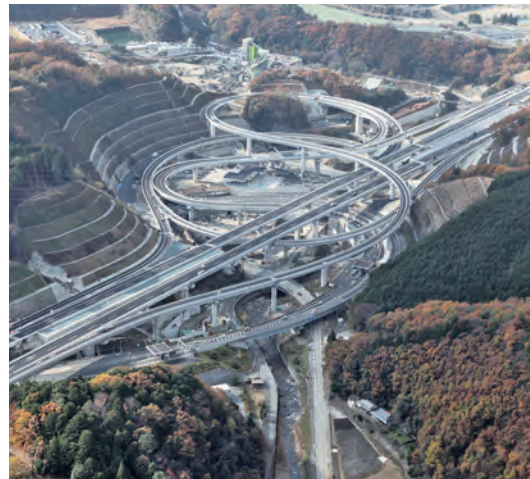
新名神高速道路路面インターチェンジ中工事(下部工)：戸田建設株式会社 新名神高速道路路面舗装工事：大成ロテック株式会社
