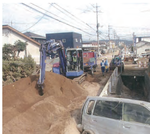
土砂撤去作業：日本道路株式会社
