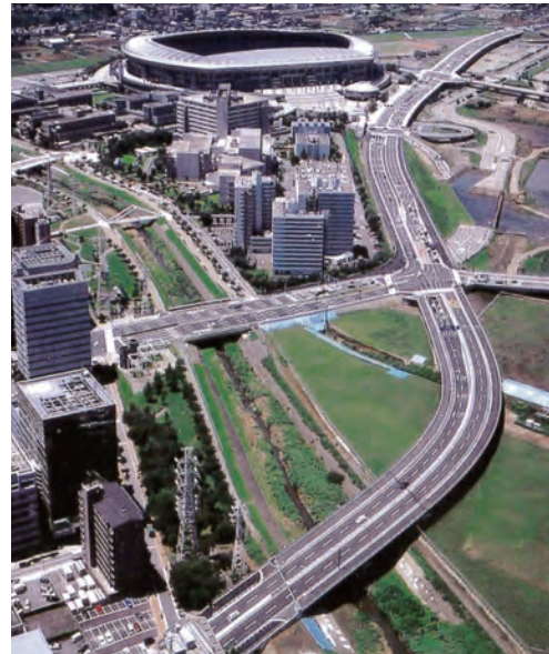
都市計画道路 新横浜元石川線 (通称：ワールドカップ大橋) (平成14年)
