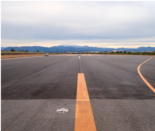
富山空港整備滑走路舗装工第8工区(富山市): 株式会社佐藤渡辺
