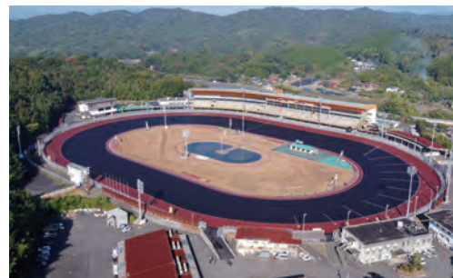
山陽オートレース場競走路改修工事(山口県山陽小野田市)(令和6年)
