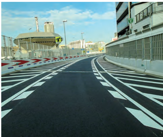
舗装補修大規模修繕工事 (2020-3-環) (大阪市 浪速区~中央区) : 世紀東急工業株式会社
