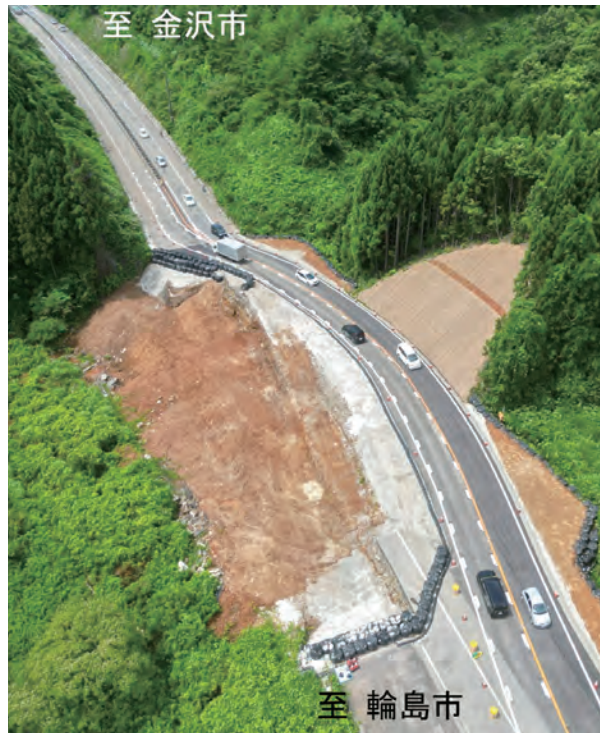
R6.7.17（2車線対面通行確保）
