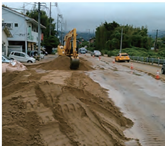
土砂撤去 185号竹原市：常磐工業株式会社
