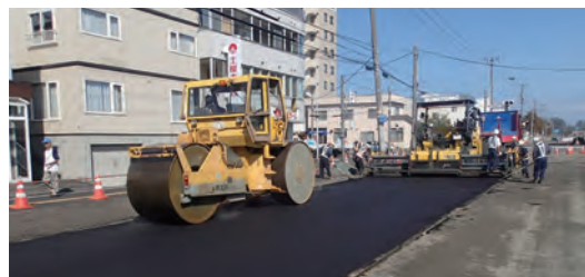
基層工舗設状況
