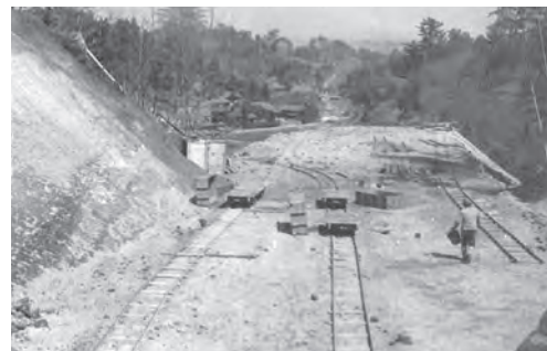
横浜市戸塚区の国道1号新路線の土木工事(昭和25年)
