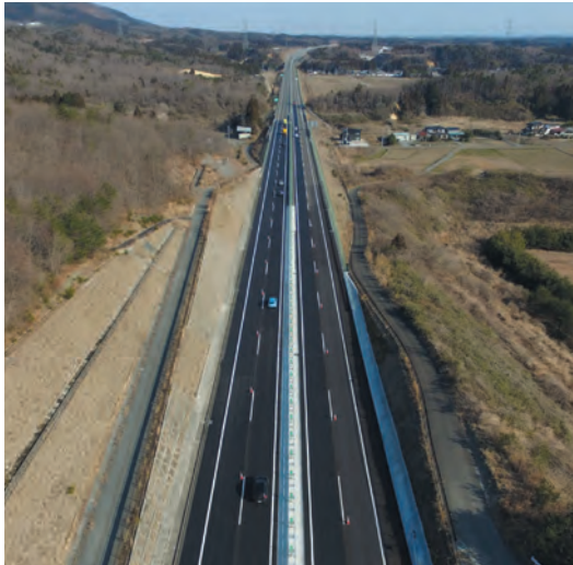
常磐自動車道 相馬工事 (福島県相馬市) : 大林道路株式会社
