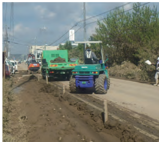
土砂撤去作業：大成ロテック株式会社
