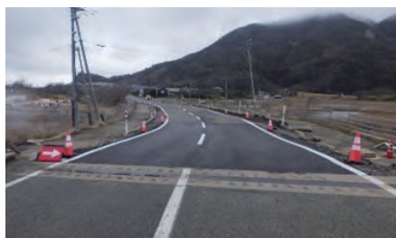
国道249号ほか路面補修・拡幅工事の状況
