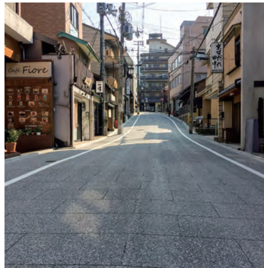
舗装道補修工事 (安井緯10号線他) (京都市東山区下河原町) : 明清建設工業株式会社
