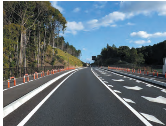
木津東バイパス木津地区舗装工事 (京都府木津川市) : 明清建設工業株式会社
