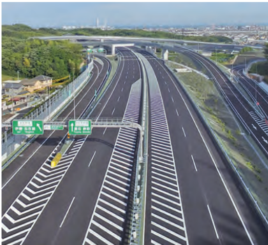
新名神高速道路 四日市舗装工事 (三重県四日市市)：大林道路株式会社
