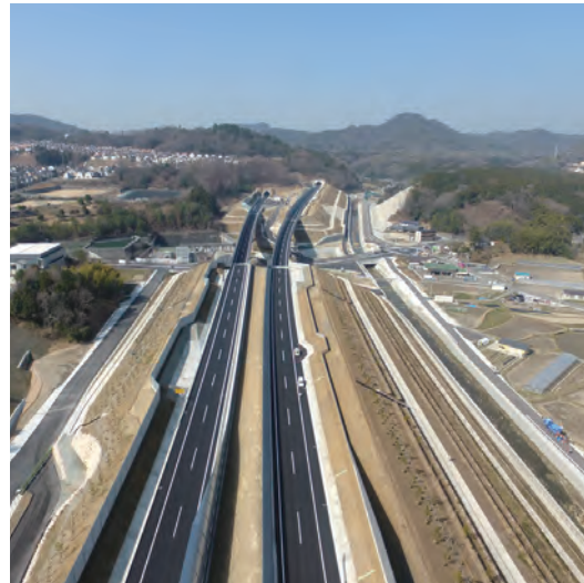
新名神高速道路 川西舗装工事：大林道路株式会社
