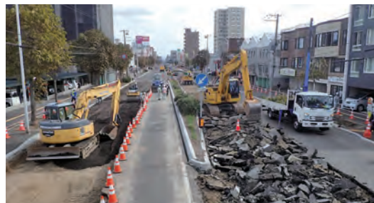
路盤工と撤去工の並行作業
