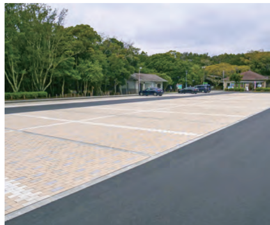
自然公園等環境整備工事足摺宇和海国立公園須ノ川 園地駐車場 (愛媛県南宇和郡愛南町) : 株式会社愛亀
