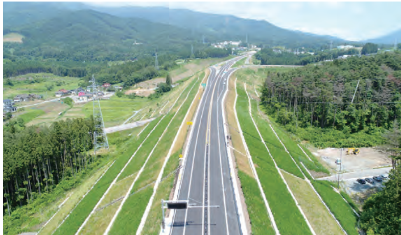
竹駒地区舗装(岩手県)：前田道路株式会社
