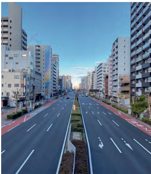
R1国道14号亀戸地区舗装修繕工事 (東京都江東区亀戸) : 株式会社竹中道路
