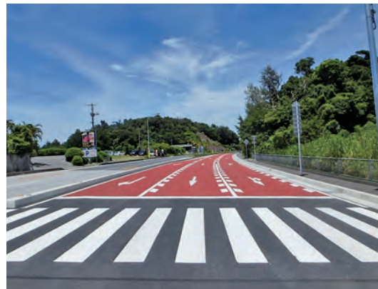
山田地区交通安全対策工事 (沖縄県国頭郡恩納村字山田)：琉球開発株式会社
