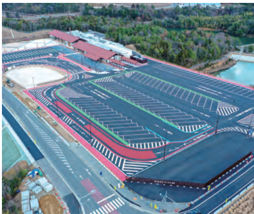
令和3年度国道2号簡易パーキング西条舗装工事 (広島県東広島市) : フジタ道路株式会社
