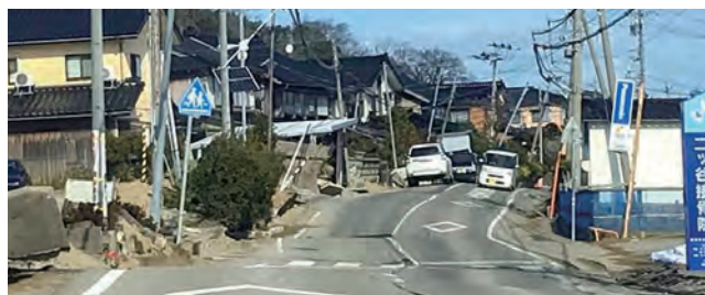
液状化(河北郡内灘町西荒屋)
