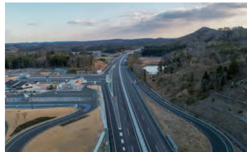
常磐自動車道 南相馬舗装工事(福島県南相馬市鹿島)(令和4年)
