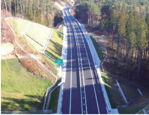
蛇王地区舗装工事 (宮城県本吉郡南三陸町志津川)：東京舗装工業株式会社
