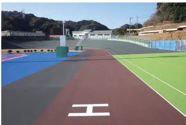
武雄競輪場走路改修工事：株式会社NIPPO
