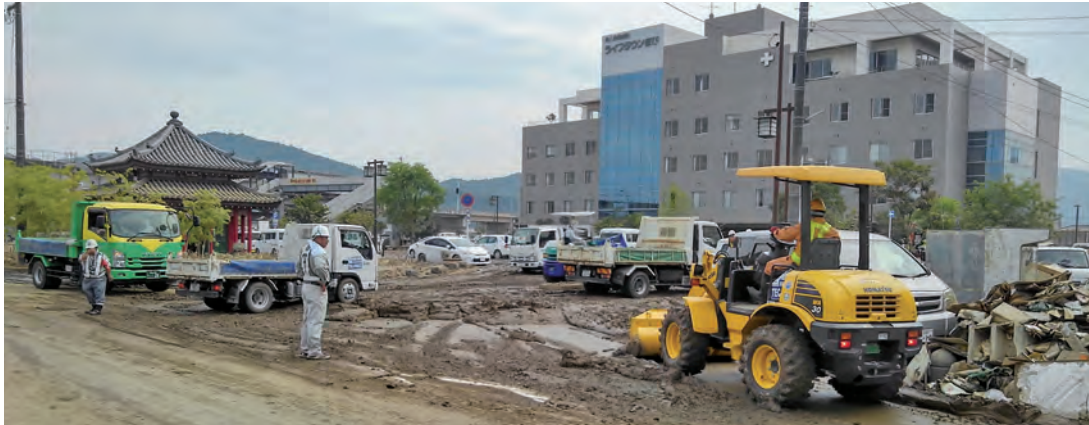
土砂などの清掃作業：大成ロテック株式会社
