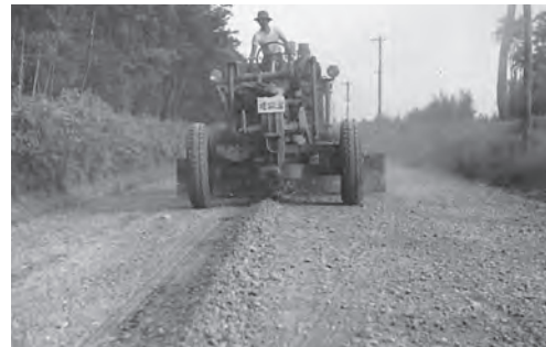
国道4号茨城県古河町のグレーダーによる路面補修工事(昭和24年)
