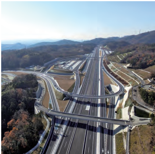
新名神高速道路 高槻舗装工事(茨木北IC)： 鹿島道路株式会社
