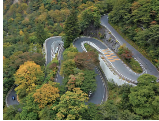
国道120号多機能型排水性舗装 (FFP) 工事 (栃木県日光市いろは坂)：株式会社ガイアート
