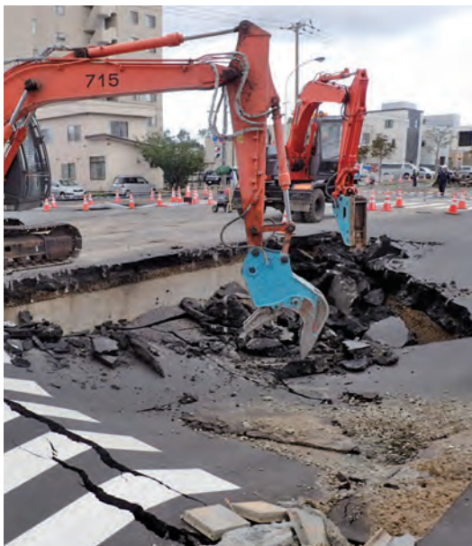
被災箇所舗装版撤去作業
