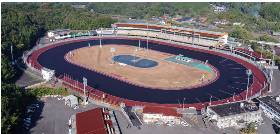
山陽オートレース場競走路改修工事 (山口県山陽小野田市) : 大成ロテック株式会社
