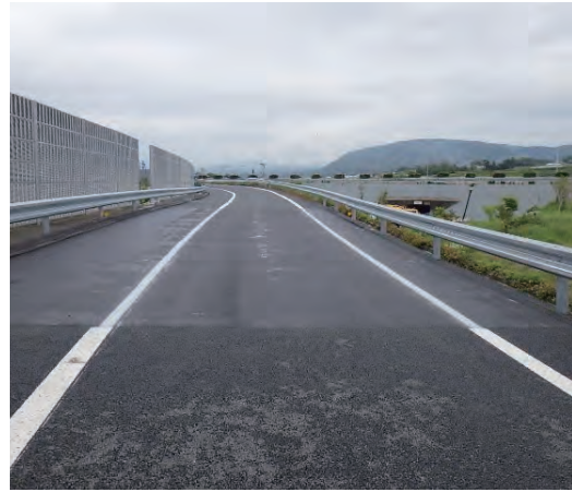
応急復旧終了
