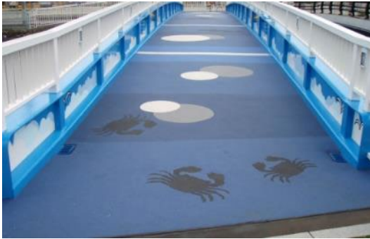
薄層樹脂舗装
