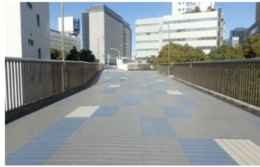
型枠式カラー舗装
