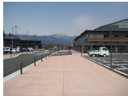
廃瓦を使用した舗装（佐藤渡辺 HP）
