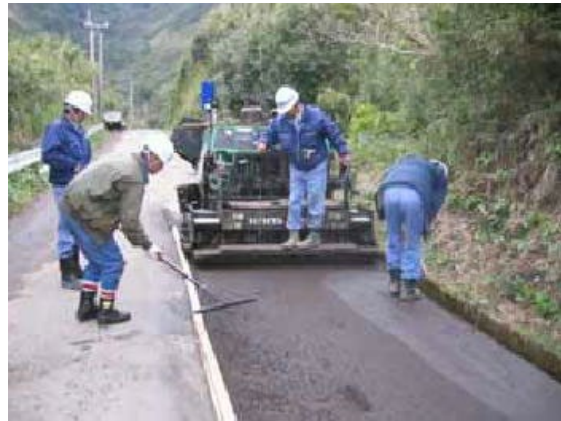
鹿児島県三島村黒島における常温再生混合物の製造と施工
