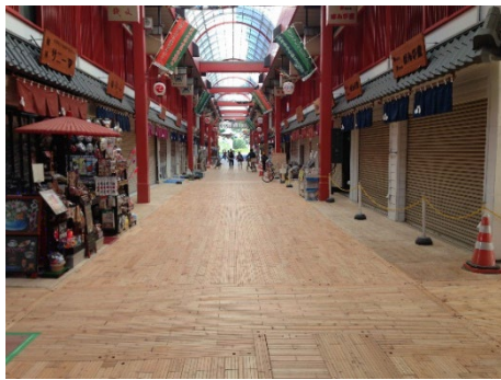
間伐材を活用したインターロッキングブロック舗装（佐藤渡辺 HP）
