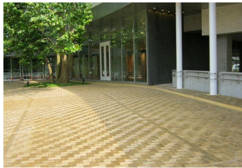
間伐材を活用したインターロッキングブロック舗装（佐藤渡辺 HP）
