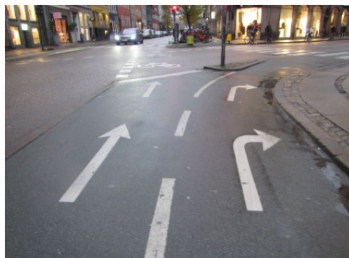
右左折の事故防止の自転車専用レーン
