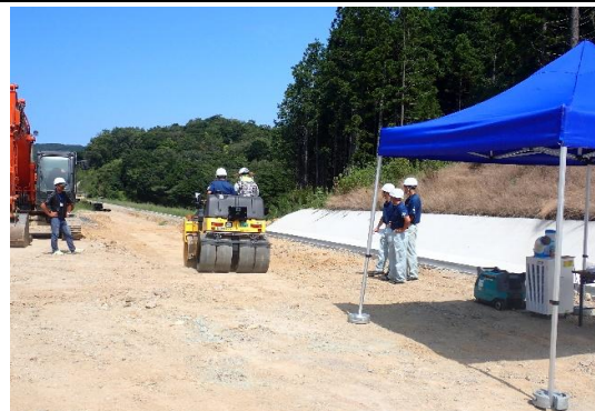
建設機械(4tコンパクトロー)の試乗
