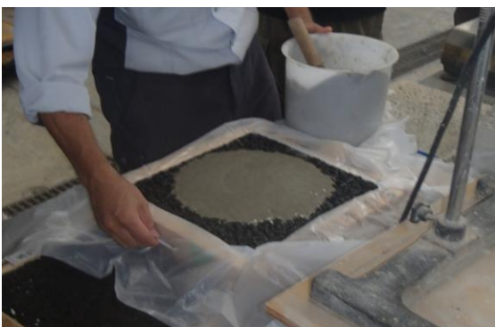
舗装技術の説明（半たわみ性舗装セメントミルク注入）
