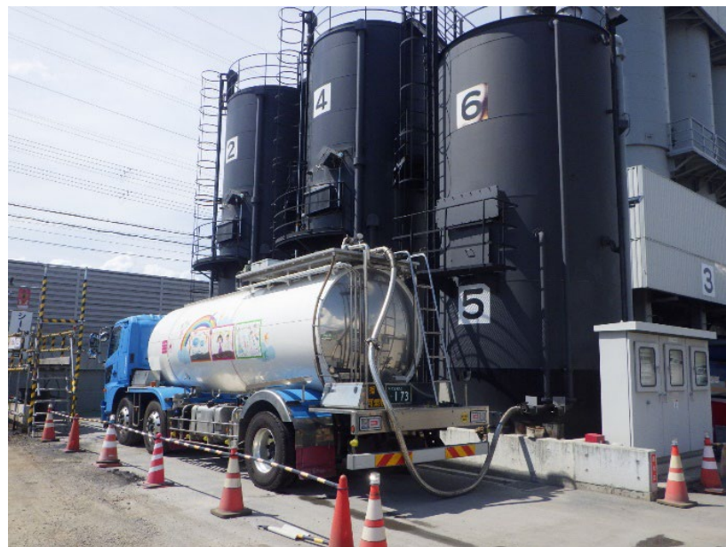
写真-中温化アスファルト搬入状況
