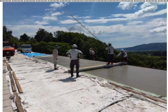
ブリツスクリッドを用いて、コンクリートの表面を平坦な仕上がりにはしています。
