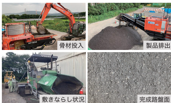
写真-2 連続製造・構内施工の状況および完成した路盤面
