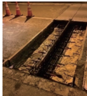
写真－３ 目地部打換え工法
