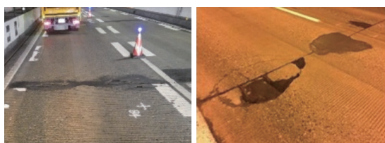
写真-1、2 コンクリート舗装横目地部変状状況
