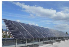
管理事務所上屋への設置（東日本高速道路(株) 東北自動車道 郡山IC）
