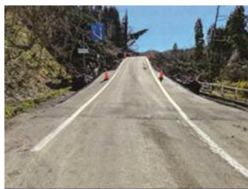
(b) 舗装応急復旧完了
